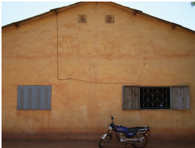
Figure 11 : Poste de surveillance de Dioïla (Région de Koulikoro)
